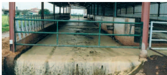
Re-utilisation du lisier liquide séparé pour le système hydrocurage
